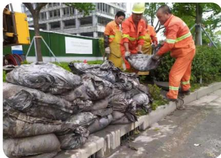
工人员只能用电钻一点点把35CM厚度的水泥层击碎，在40米至72米不等长的管道内，又缺氧，又阴暗，进行人工作业，每推进一米都无比艰辛，膝盖磨出水泡、出血，都习以为常。养护人员不叫一声苦，齐心协力，装、挖、
