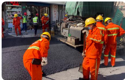
统是以性能处于国际领先的高粘高弹沥青和高粘改性乳化沥青为混合料和粘结层的胶结料，采用先进同步摊铺施工工艺，实施厚度为 2.0cm 的高性能沥青混凝土面层，优点如下：相较于传统的磨耗层，具有优越的抗裂、抗渗和抗滑性能，可有效提升路面平整度；显著降低行车噪音，相比于水泥混凝土路面降低交通噪音 5-7 分贝；耐久性能优越等。
