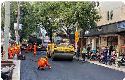
本次市政养护中修工程包含南中路（贝港桥—城乡路）、菜场路（南亭公路—新建西路）、立新路（南奉公路—解放中路），主要施工内容为：车行道原路面病害修复和标高处理后加铺 2.0cm 高韧超薄沥青磨耗层，人行道面层翻新为仿石砖，侧平石翻新，窨井抬升等道路附属工程。
