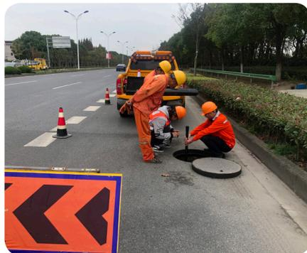
缺陷（如沉积、漂浮物）点位，对下水道进行全面体检，快速进行针对性的专业疏通和修补。当管道内水量较少水流平缓或者干井，可将潜望镜检测机器人放入排水管道，将管道内的实时图像传输到控制端。工作人员通过控制端直观地观察管道内的情况，对排水管道或管网进行快速视频勘查验收、普查评估。
