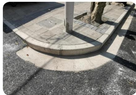
道路边缘进水口，通过对平石外形调整，进水口处进行凹陷处理，大大提升积水的消退速度，使道路积水的可能性进一步减小，避免一下雨就“看海”的尴尬情形。
