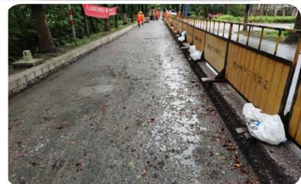
风吹刮而易倒的护栏绑扎牢固、防撞水桶“加料”增重。
