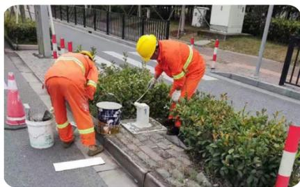
为确保刷漆施工质量，养护人员在刷新前对上述公路设施进行表面清理，做好板面剥落、气泡及污秽的清除工作，增加油漆牢固度。
