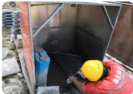
人行道弯头处理方面，摒弃以往小型预制块石拼接的工艺，采用定型模具预制等距弯头的方式，减少拼接数量，大大提高整体强度，带来良好的观感，拼接块数的减少带来的是道路拐角更强的整体性。
