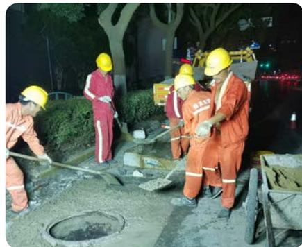
格遵守快速混凝土的用料配比进行操作。直至凌晨五点，所有沥青摊铺工作完成，交通恢复正常。
