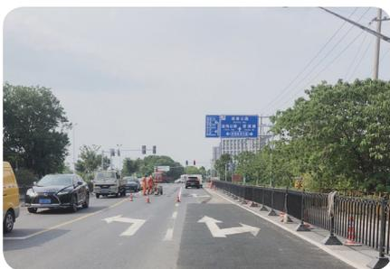
经过道班人员现场测量，结合施工图纸和现场实际，最后本次施工方案为，将渠化段往南增加至45米，渐变段同步增加至30米，涉及下行段的机
