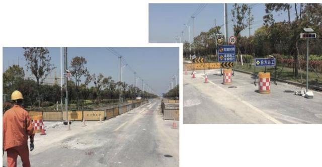
海航路位于柘林镇建筑垃圾处置场北面，每天都有密集的大型超载土方车经过，导致该路面大量出现坑塘、深陷等病害，严重影响路面正常运行及车辆和行人的安全出行。面对这一现象，公司迅速安排养护项目部进行海航路路面勘察并采取施工措施拟定计划。争取在最短的时间内把损坏的路面恢复原样，把社会的反响降到最小化。
