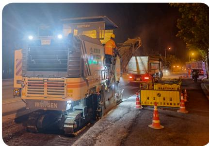
按照单根车道施工完后进行另一根车道铣刨原则，施工车道与非施工车道使用将军帽分隔，并在施工过程中安排专人指挥交通，保证施工期间社会车辆正常通行，不占用对向车道，下午4点至7点避开晚高峰停止施工。在项
