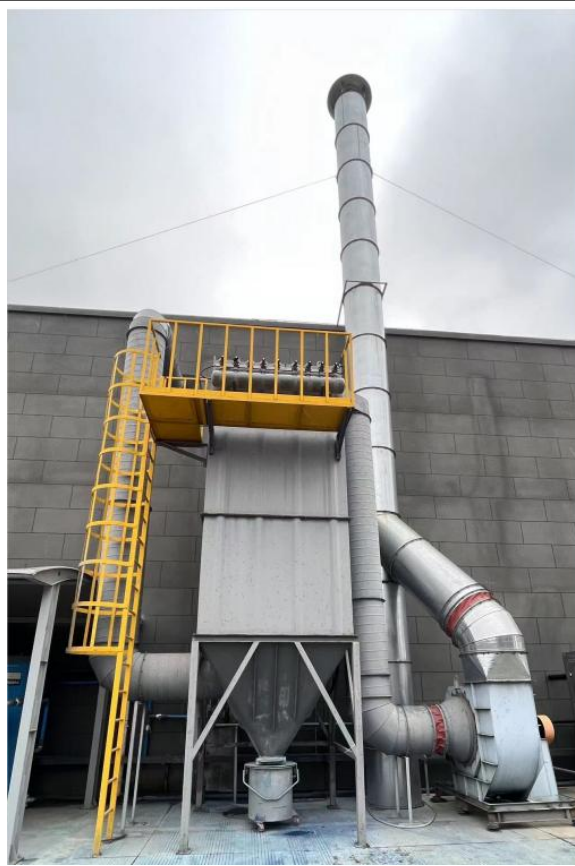
图 3-2 投料/包装粉尘废气治理设施照片
