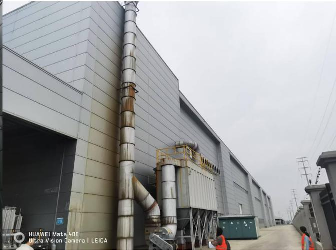
熔化废气治理设施（布袋除尘器）
