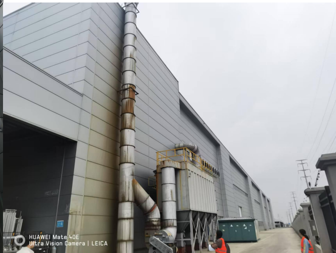
熔化废气治理设施（布袋除尘器）
