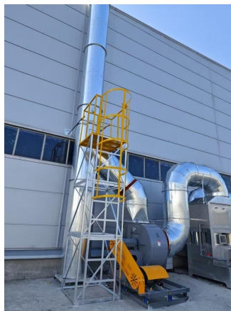
熔化废气治理设施（布袋除尘器）
