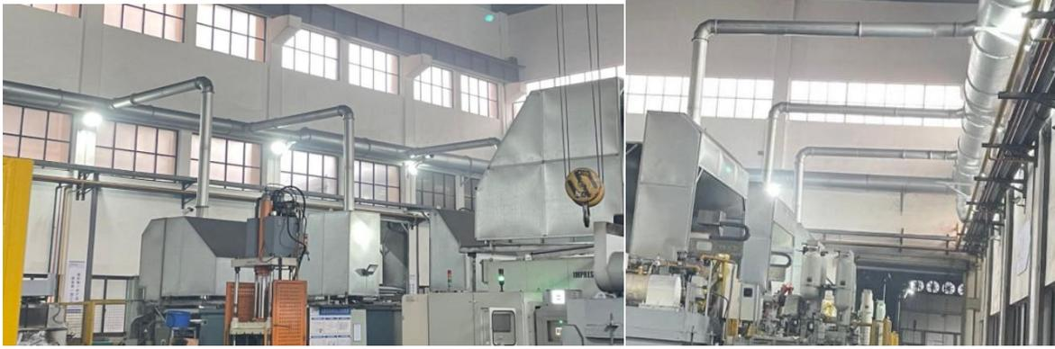
图 4-2 压铸脱模废气治理设施
