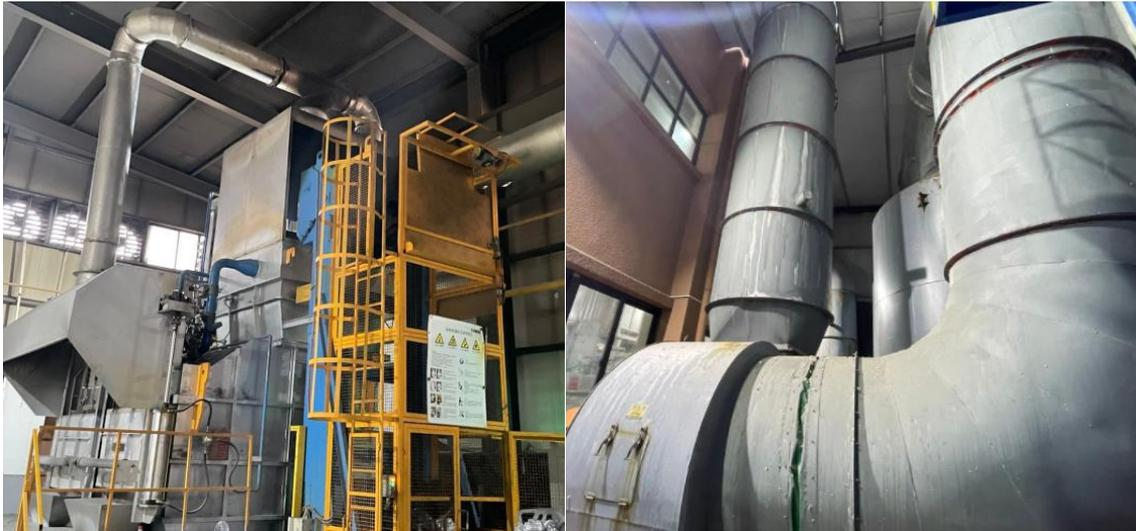
图 4-2 熔化烟尘及燃气烟气治理设施
