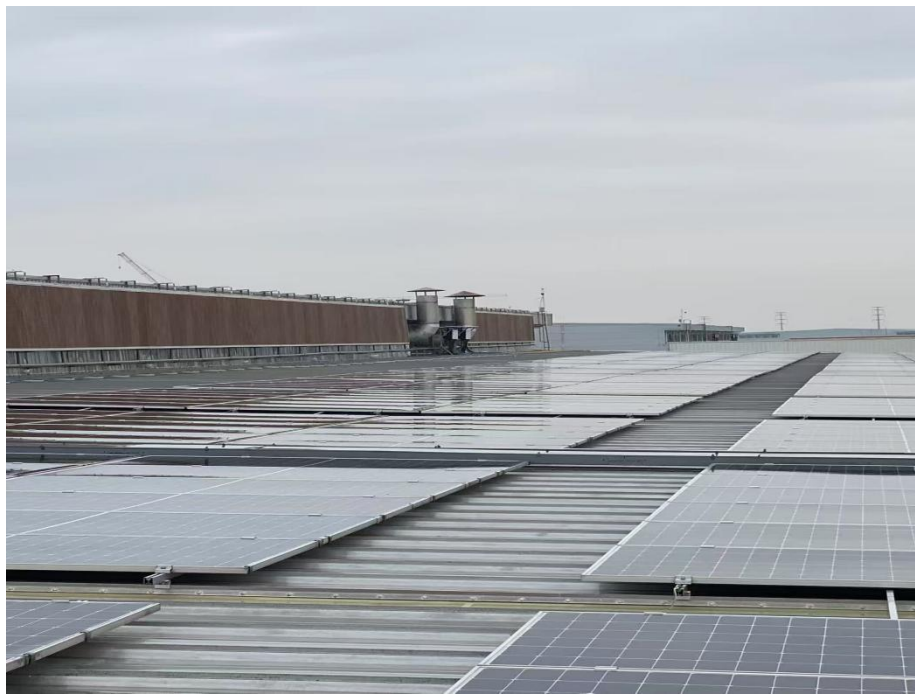
A 车间天然气燃烧废气排气筒
