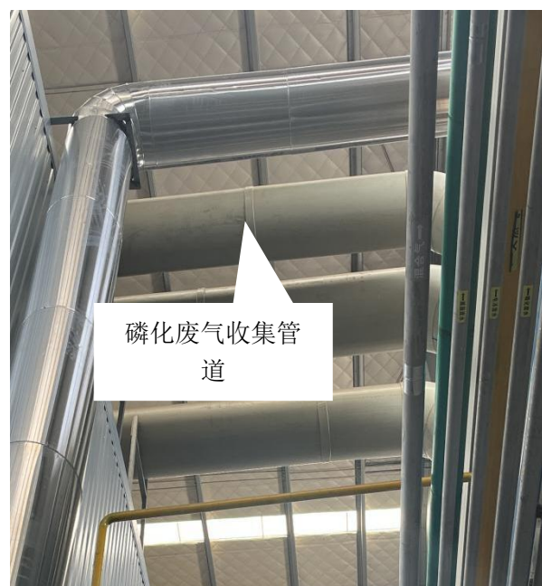
C 车间磷化废气收集管道
