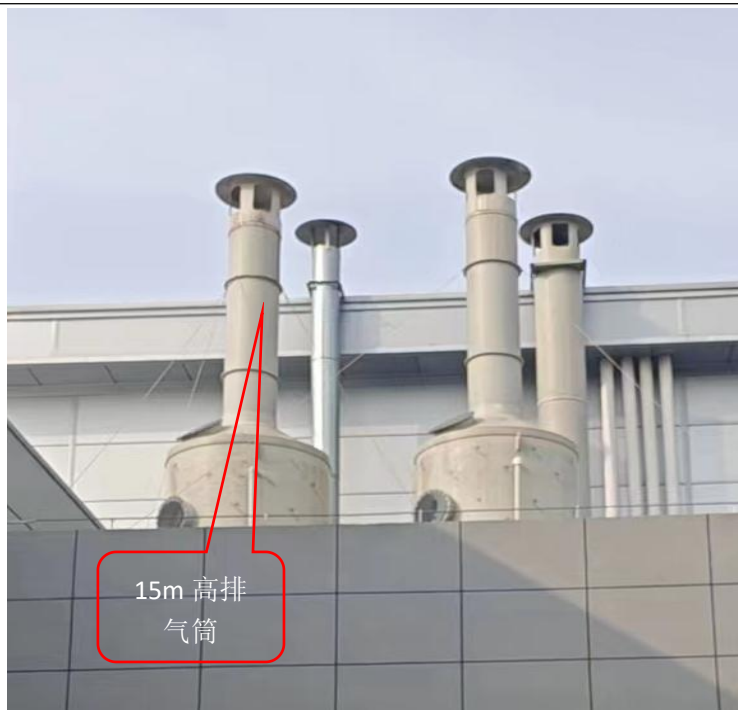
C 车间磷化废气排气筒
