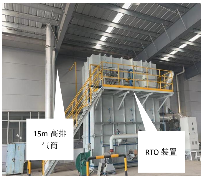
C 车间电泳/烘干废气治理设施、排气筒
