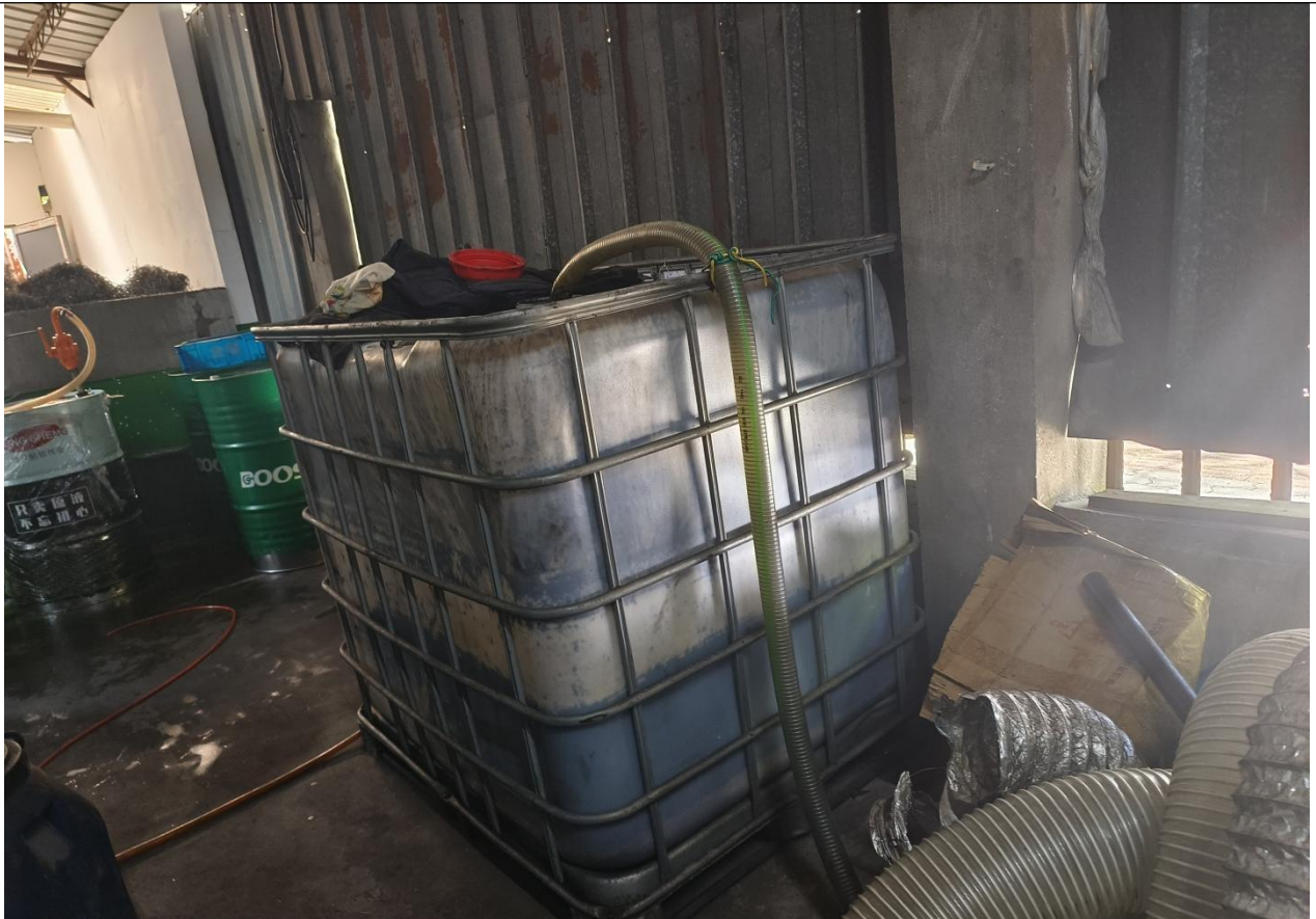
图 3-2 生产废水收集吨桶
