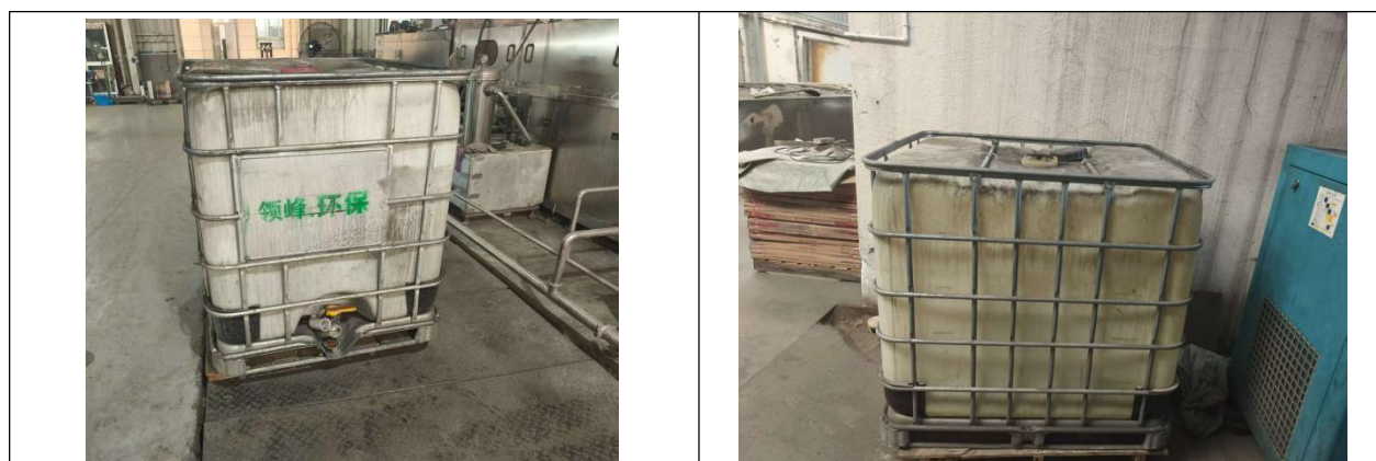
图 3-2 生产废水暂存桶 表 3-2 废水治理设施一览表
