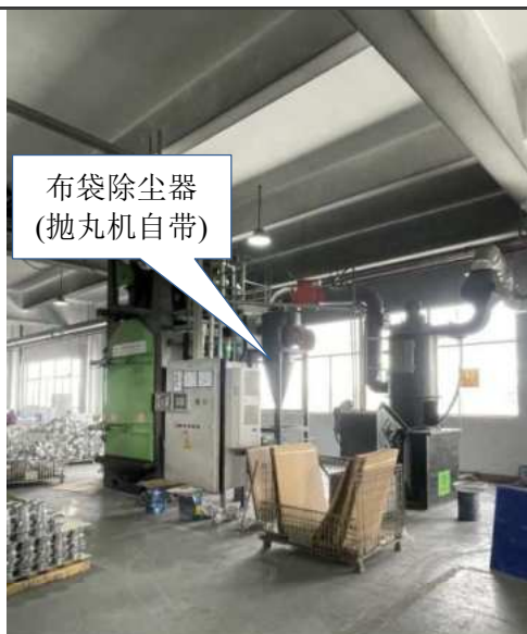
图 3-8 抛丸废气治理设施照片
