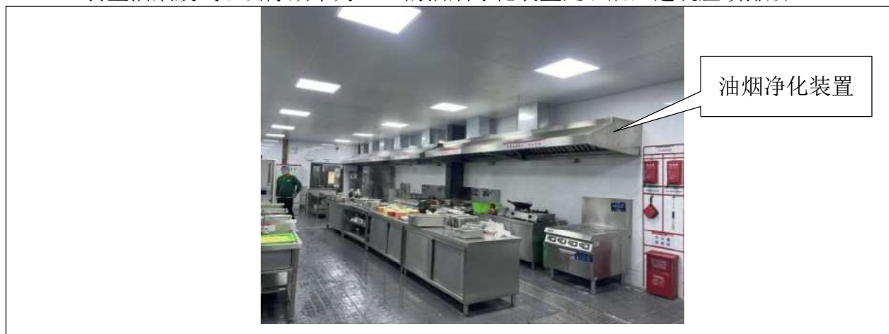
图 3-10 油烟净化装置照片
