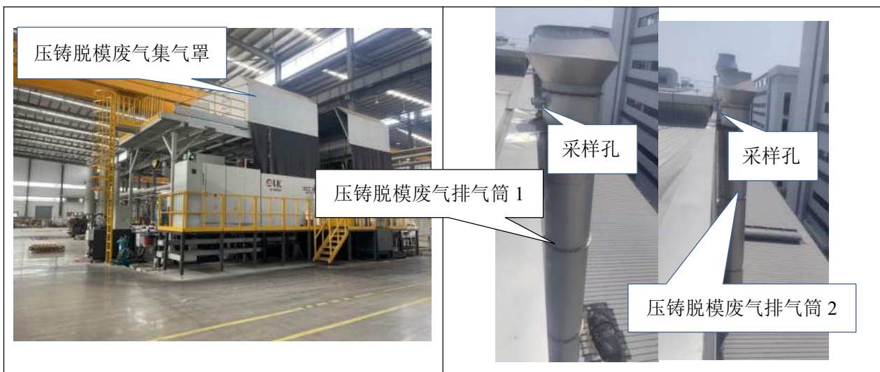
图 3-6 压铸脱模废气治理设施照片
