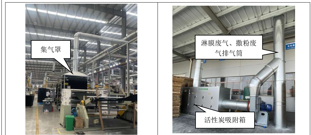
图 3.7 淋膜废气及撒粉废气治理工艺流程图
