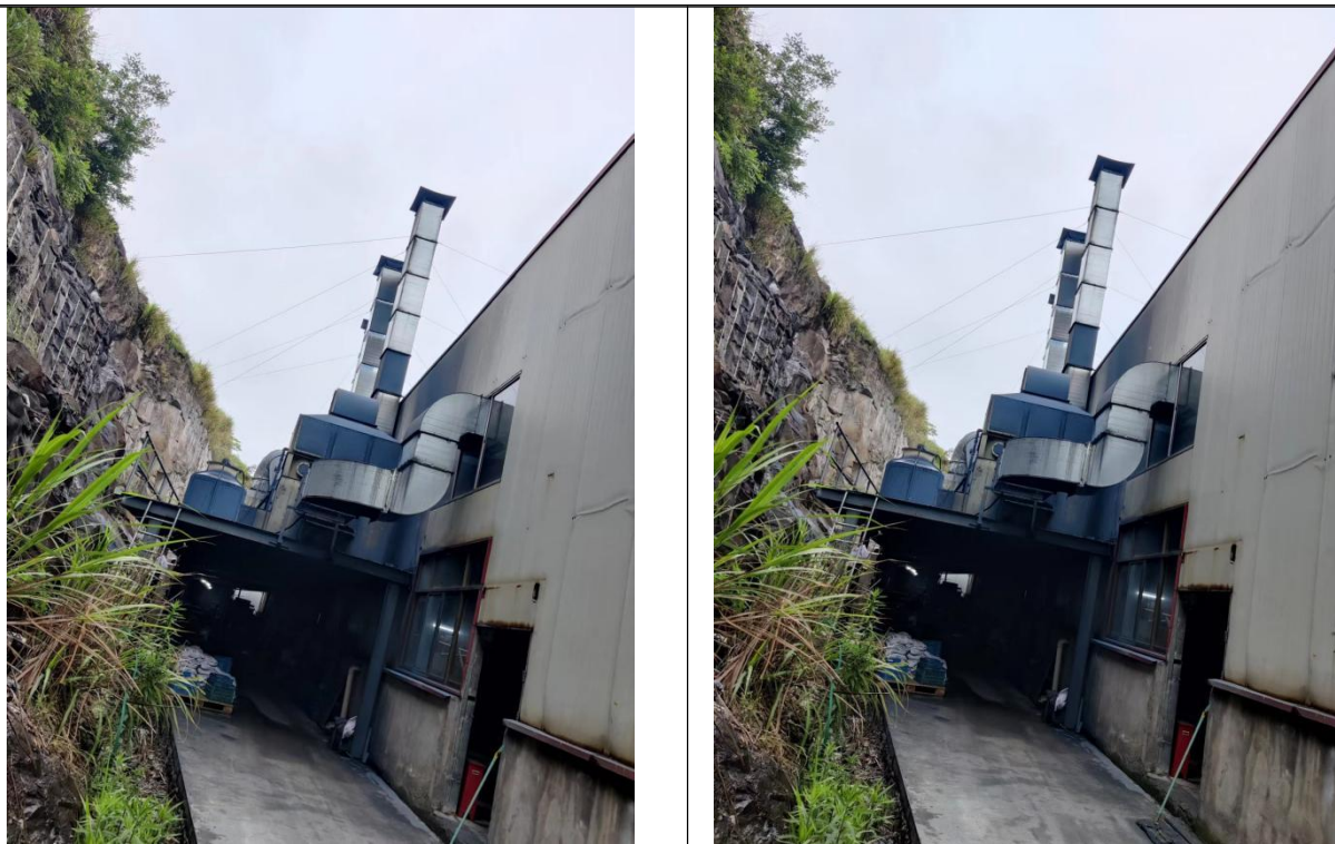
图 3-2 喷涂废气环保设施
