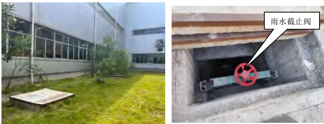
图 4.2-2 事故应急池照片
