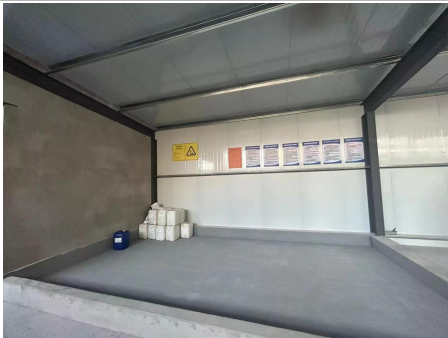
危废暂存间内部
