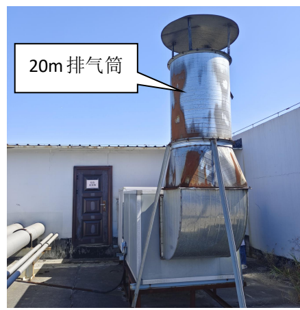
图 3-2 锡膏印刷废气、回流焊废气、三防漆喷涂/固化废气治理设施照片
