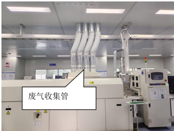
图 3-2 锡膏印刷废气、回流焊废气、三防漆喷涂/固化废气治理设施照片
