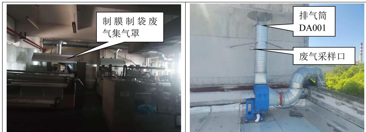
图 3-2 挤塑废气治理设施照片
