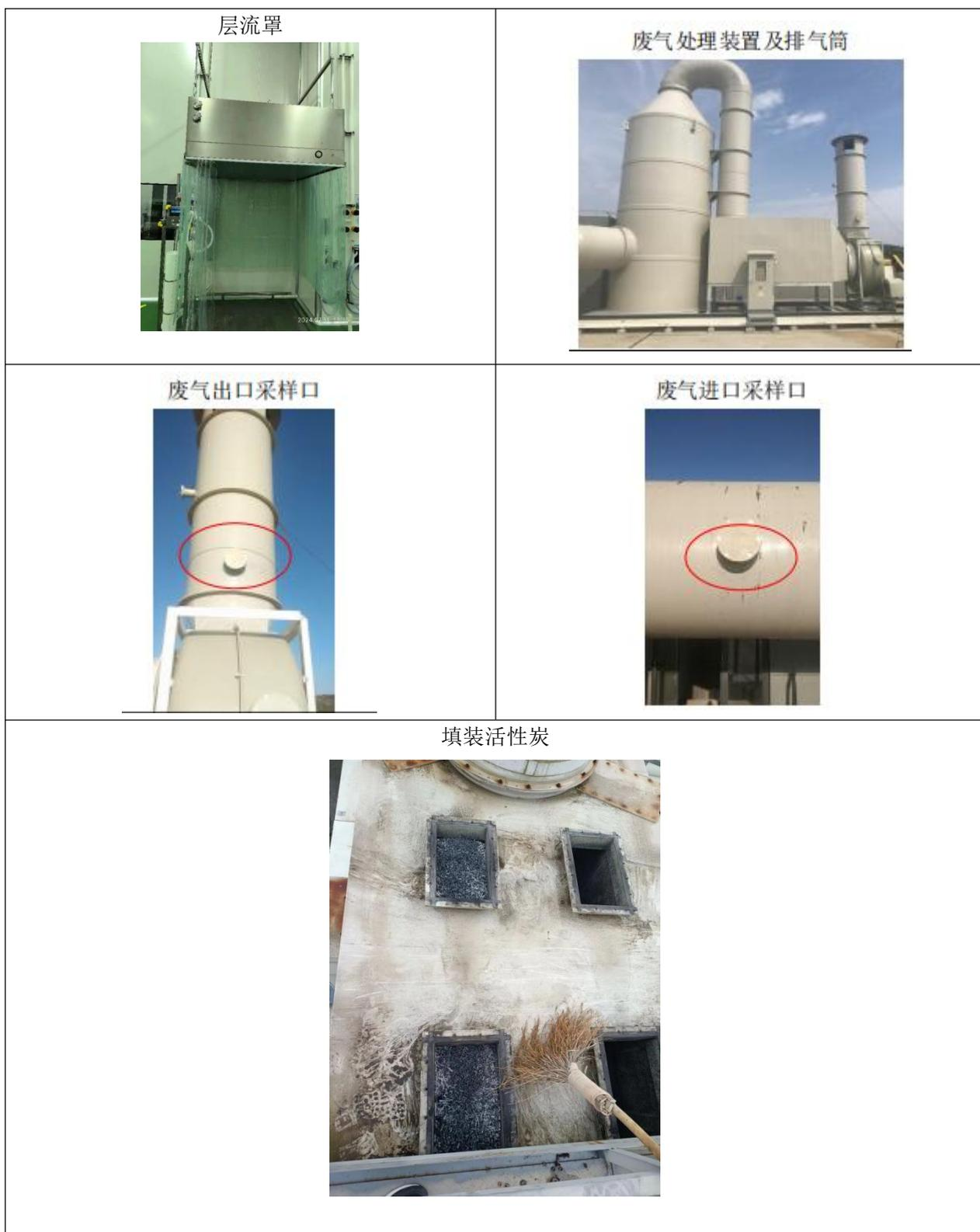
图 4.1-2 生产车间废气治理设施照片
