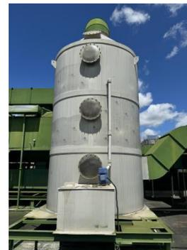
喷漆、烘干废气处理设施（喷淋塔）
