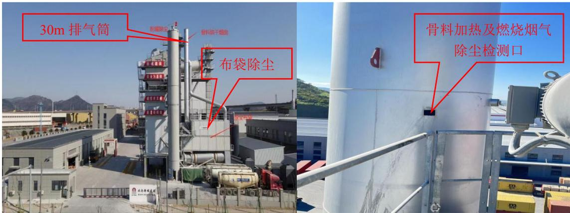
图 3-1 骨料加热粉尘及燃烧烟气治理照片
