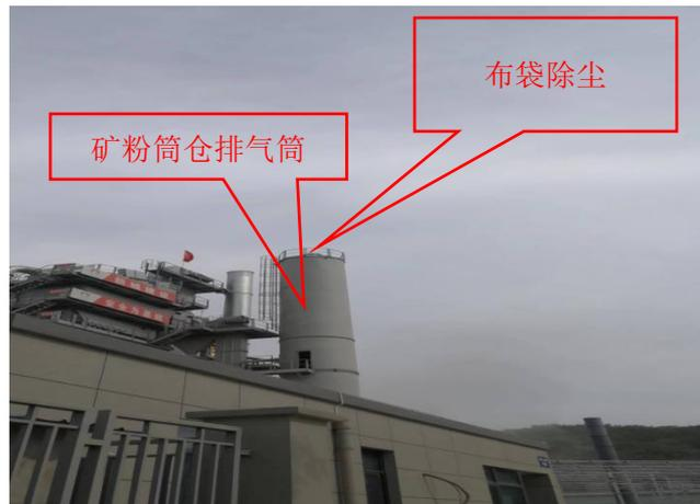
图 3-4 矿粉筒仓粉尘治理照片
