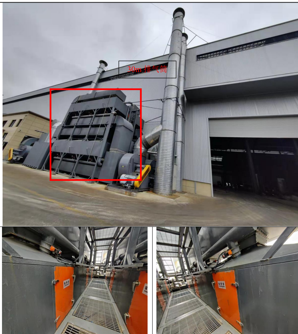
图 3-6 喷涂废气处理设施
