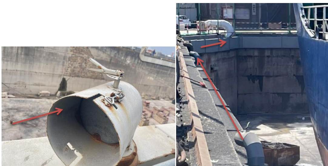
图4-5 废气收集排放
