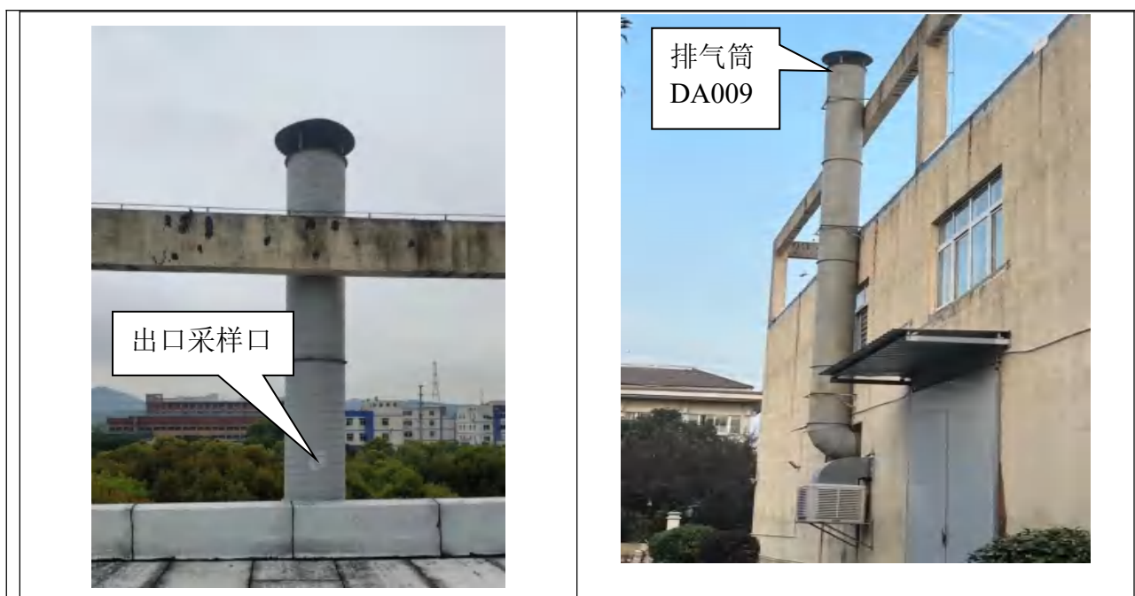
图 3-4 不锈钢龙头抛光粉尘、喷砂粉尘治理设施照片
