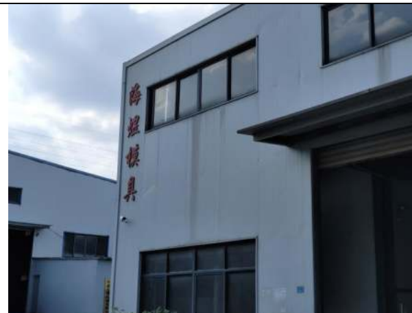
项目北侧-宁波北仑海煜模具科技有限公司
