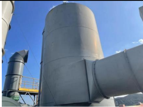
熔化烟尘和压铸脱模废气治理设施
