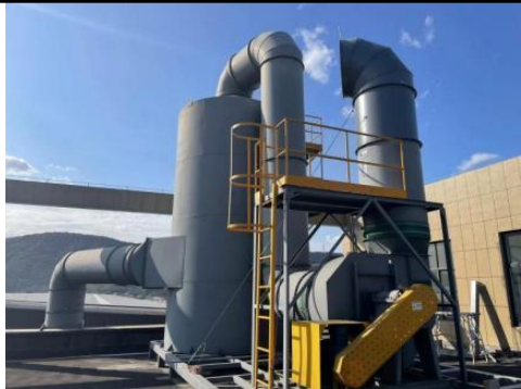
熔化烟尘和压铸脱模废气治理设施
