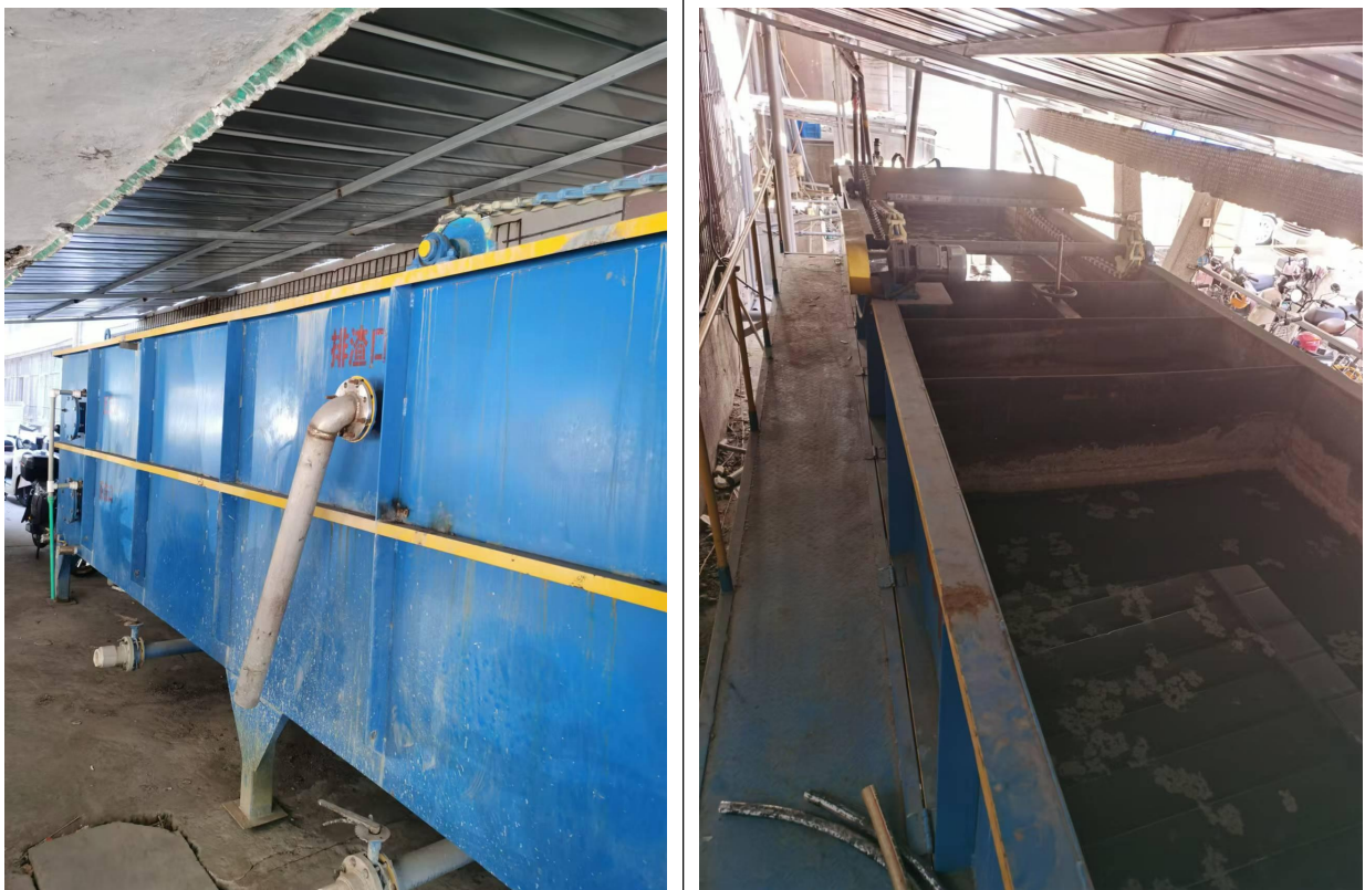
图 3-4 厂区污水处理站照片
