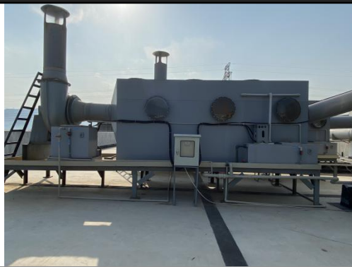
酸洗废气（氯化氢）碱液喷淋塔
