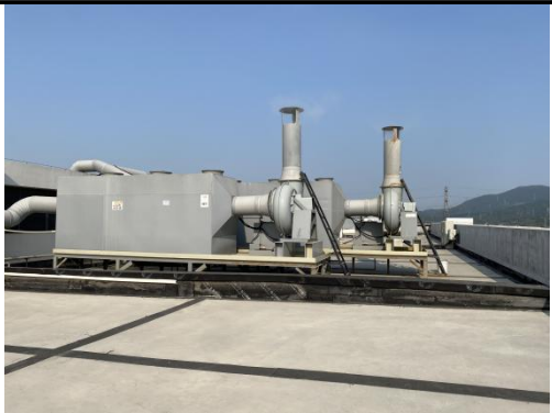
蚀刻废气（氯化氢）碱液喷淋塔
