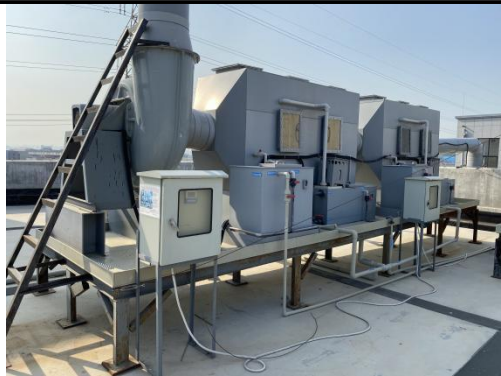
蚀刻废气（氟化氢）碱液喷淋塔
