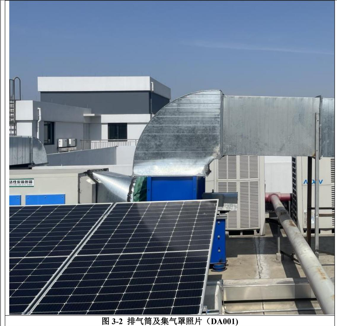
图 3-2 排气筒及集气罩照片 (DA001)
