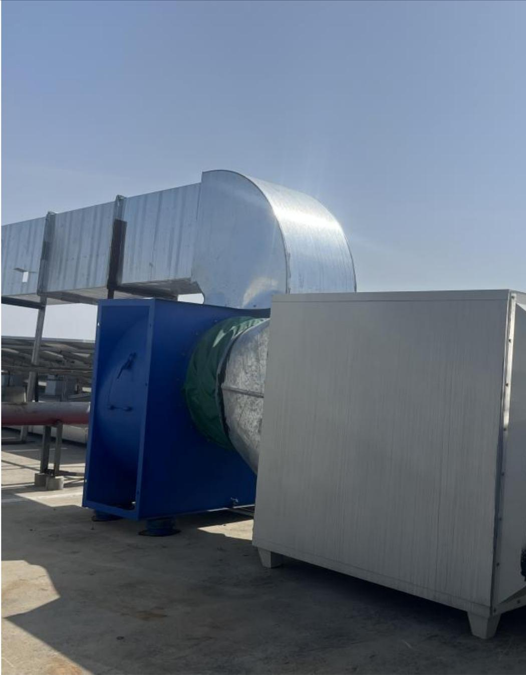
图 3-2 排气筒及集气罩照片 (DA002)
