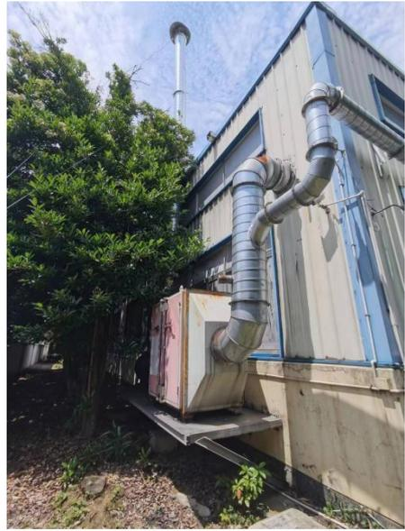
图 3-2 热熔挤出废气治理设施照片
