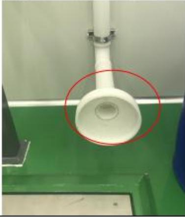
固体原料投料废气集气口
