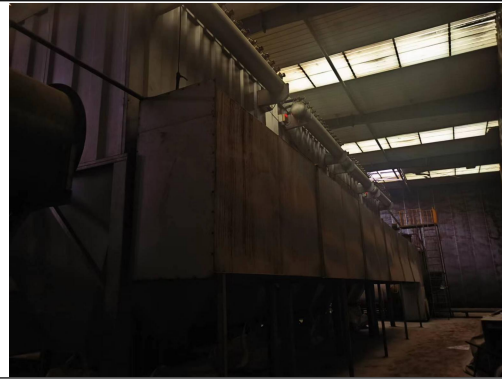
天然气熔化炉烟气治理设施
