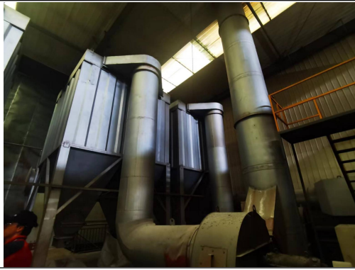
天然气熔化炉烟气治理设施
