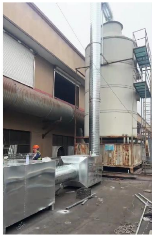
电保温炉烟气、压铸脱模废气治理设施
