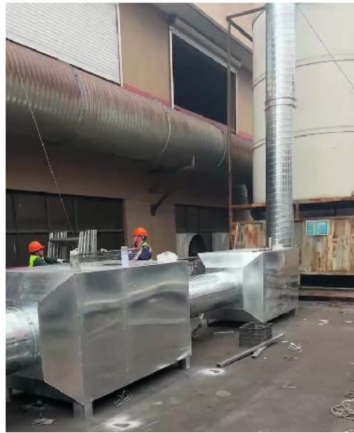
电保温炉烟气、压铸脱模废气治理设施
