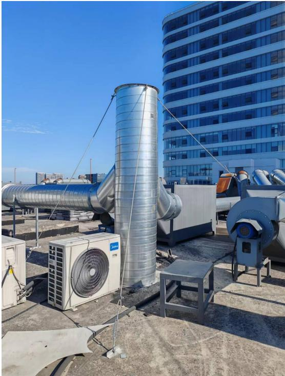
隧道炉天然气燃烧废气
