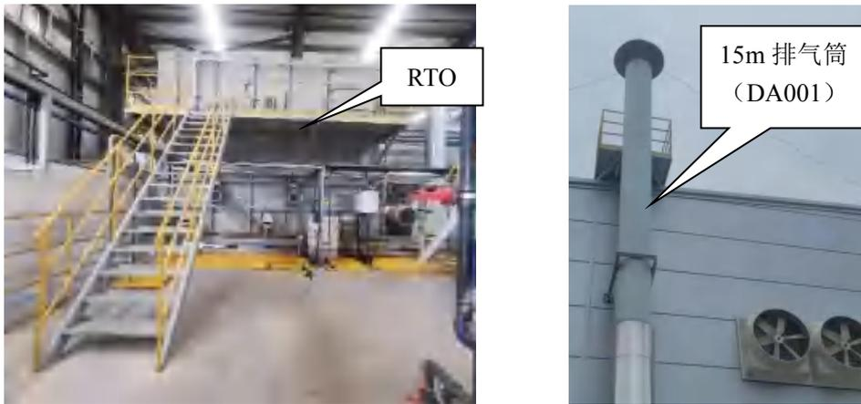
图 3-2 电泳/烘干废气、RTO 天然气燃烧废气治理设施照片
