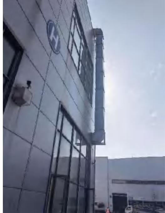
图 3-2 抛丸粉尘废气治理设施照片
