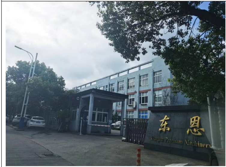
项目西面（宁波东恩精密机械有限公司）
