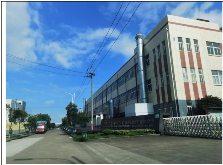
项目东侧（宁波景升明诚汽车科技股份有限公司）
