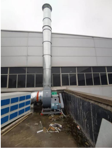
模压废气排气筒（DA029）
