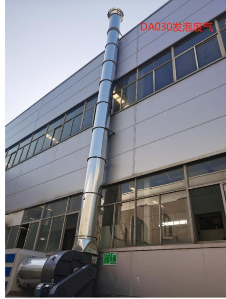
发泡废气和脱模废气排气筒（DA030）
