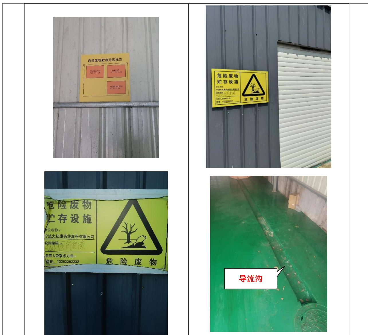
图3-8 危险废物临时仓库
