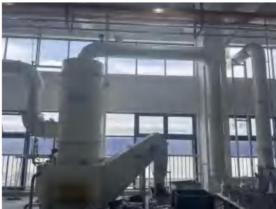
图 3-6 抛丸粉尘治理设施照片
