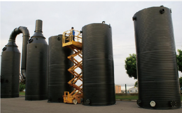
大型化学工艺罐体
