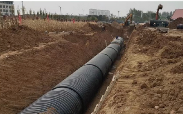
市政雨污水管道
