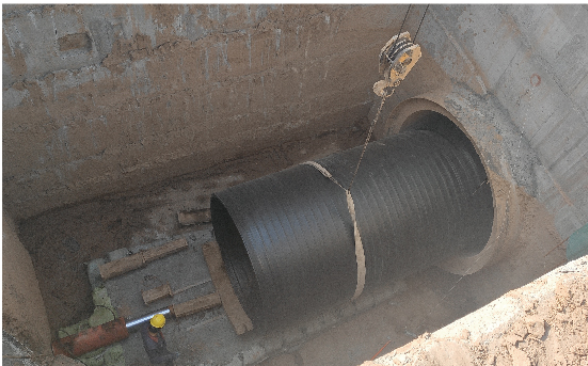
穿越铁道下方DN2400雨污水管道
