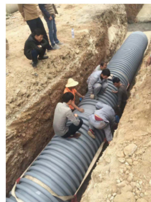
广东某生态城市市政管道系统 DN1200聚丙烯PP管道
